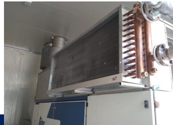
Microturbina a gas con inlet conditioning
